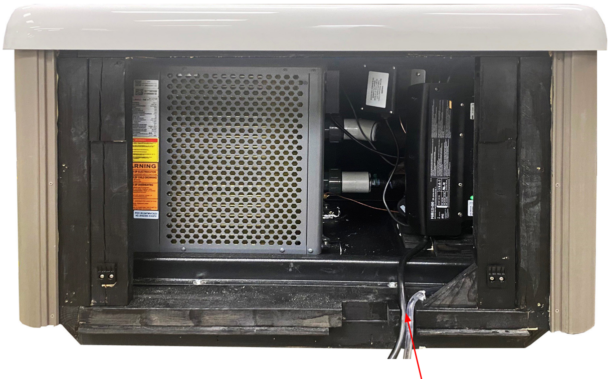
Câble d'alimentation et tube de vidange dans la zone de découpe
