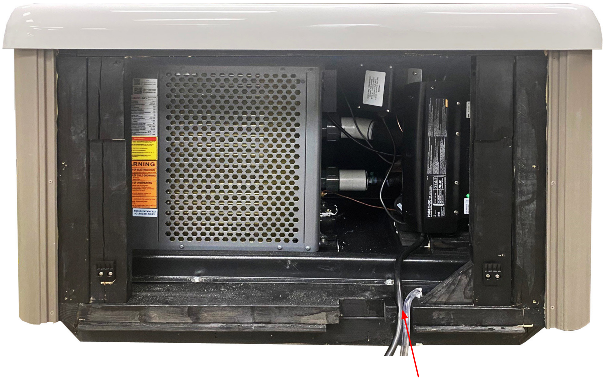
Cable de electricidad y tubo de desagüe en la zona recortada
